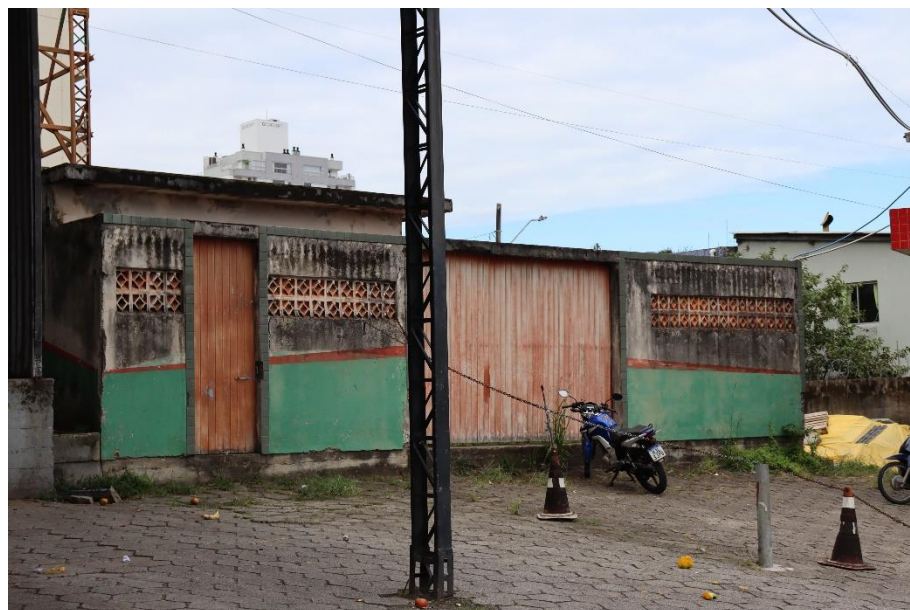
Casa das Bombas
