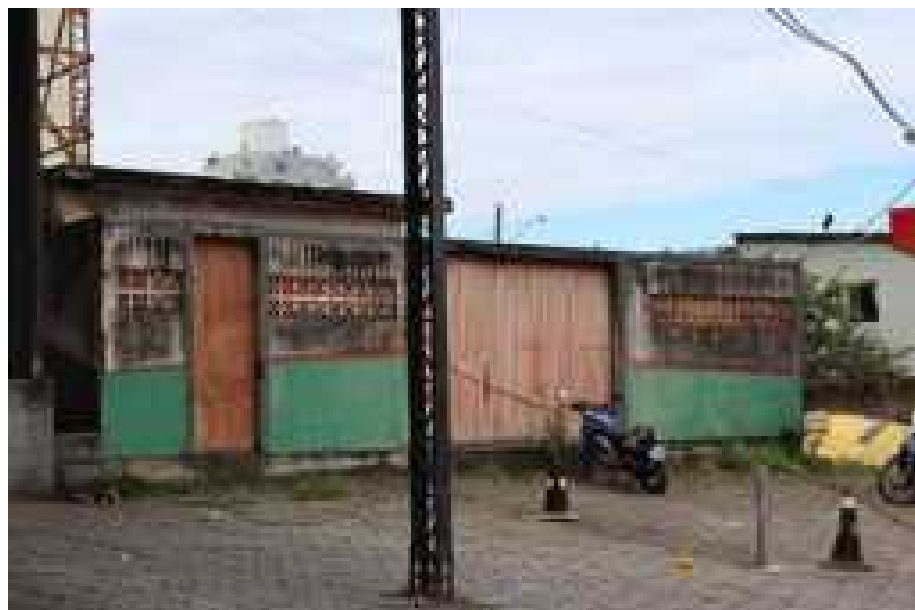
Casa das Bombas
