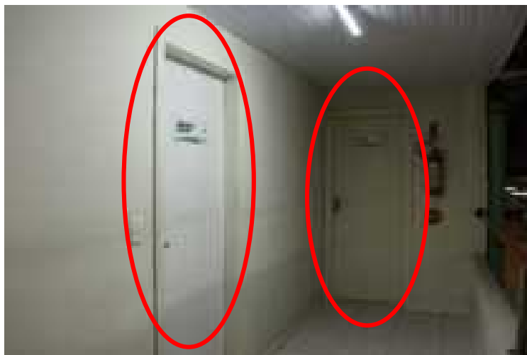
Sala da Gerência e Auditório
