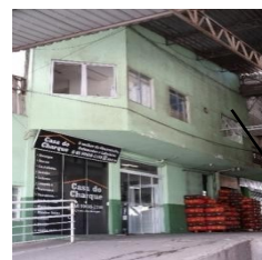
Área externa dos boxes na parte inferior do prédio
