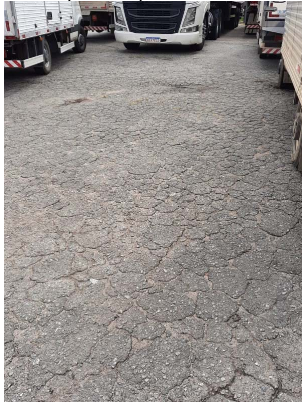
Figura 11 - Superfície do pavimento do estacionamento
