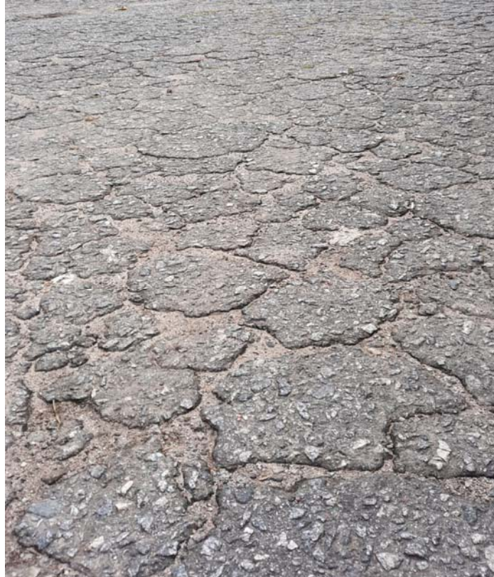
Figura 13 - Superfície do pavimento do estacionamento
