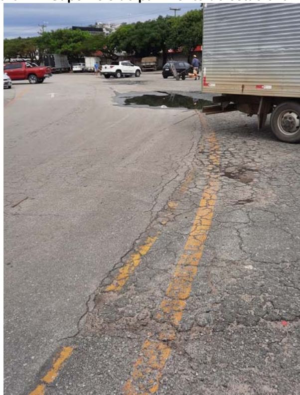
Figura 12 - Superfície do pavimento do estacionamento
